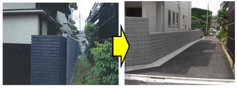
避難路整備（道路の拡幅）
