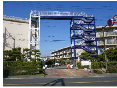
既存施設（市営住宅等）への 避難階段設置
