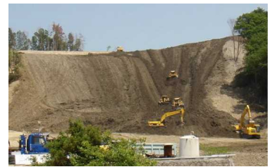
盛土撤去工事のイメージ
