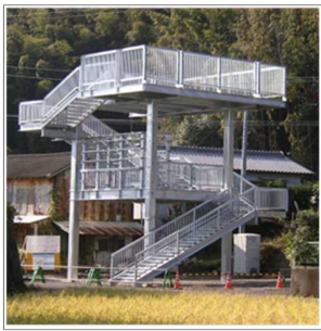
津波避難タワーの整備
