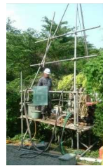
安全性把握調査 (ホーリング調査)
