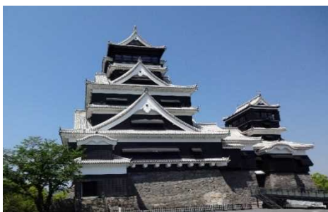
天守閣の復旧完了(令和3年3月)
