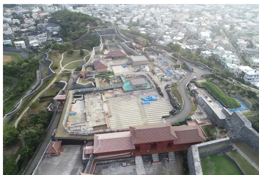
○令和元年10月の火災により正殿を含む9施設が焼失（一部焼失含む）した国営沖縄記念公園首里城地区（令和4年1月時点）
