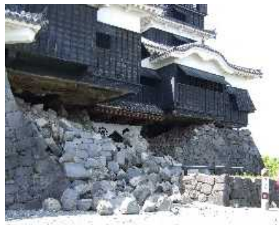
熊本地震により被災した天守閣(左:瓦の多数崩落、右:石垣の一部崩落)
