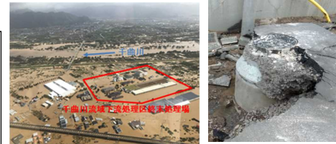
令和元年東日本台風で浸水した下水処理場 千曲川流域下流処理区終末処理場 北海道胆振東部地震で液状化した長野県 千曲川流域下流処理区終末処理場 管路の被害(北海道札幌市)
