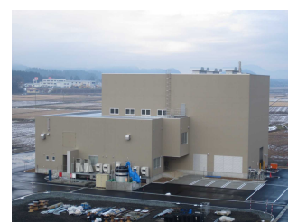
【汚泥資源化施設概要】 処理方式:炭化による資源化 処理能力:約7,800 ton/年
